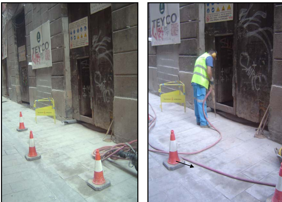
Fig 4. Foto espai d'intervenció abans del començament i picat del paviment superficial (Unitat estratigràfica 100).
