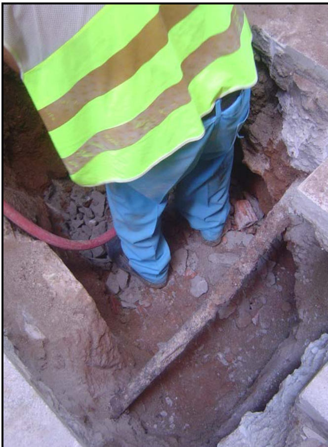
Imatge del picat mecànic de sector W, on trobem la riostra lateral de la nova construcció.
