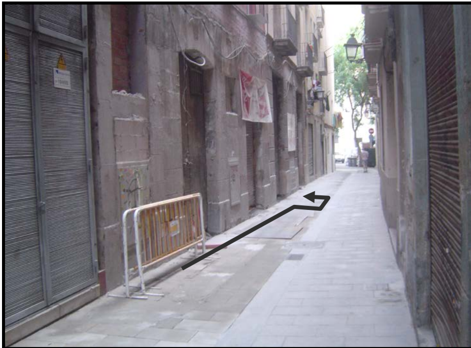
Fig 2. Espai concret d'actuació. La fletxa negra senyala l'ubicació de la rasa efectuada al carrer de Sant Pere Mitjà.
