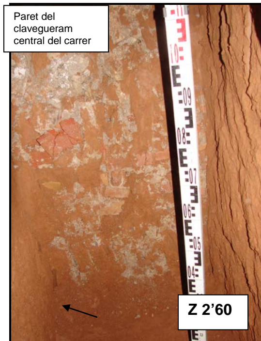
Fig 7,8 i 9. Fotografies finals de la rasa. Detall contacte amb la paret del clavegueram central del carrer.
