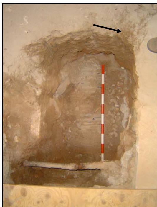
Fig 6. Detall de la canalització /claveguera de PVC.
